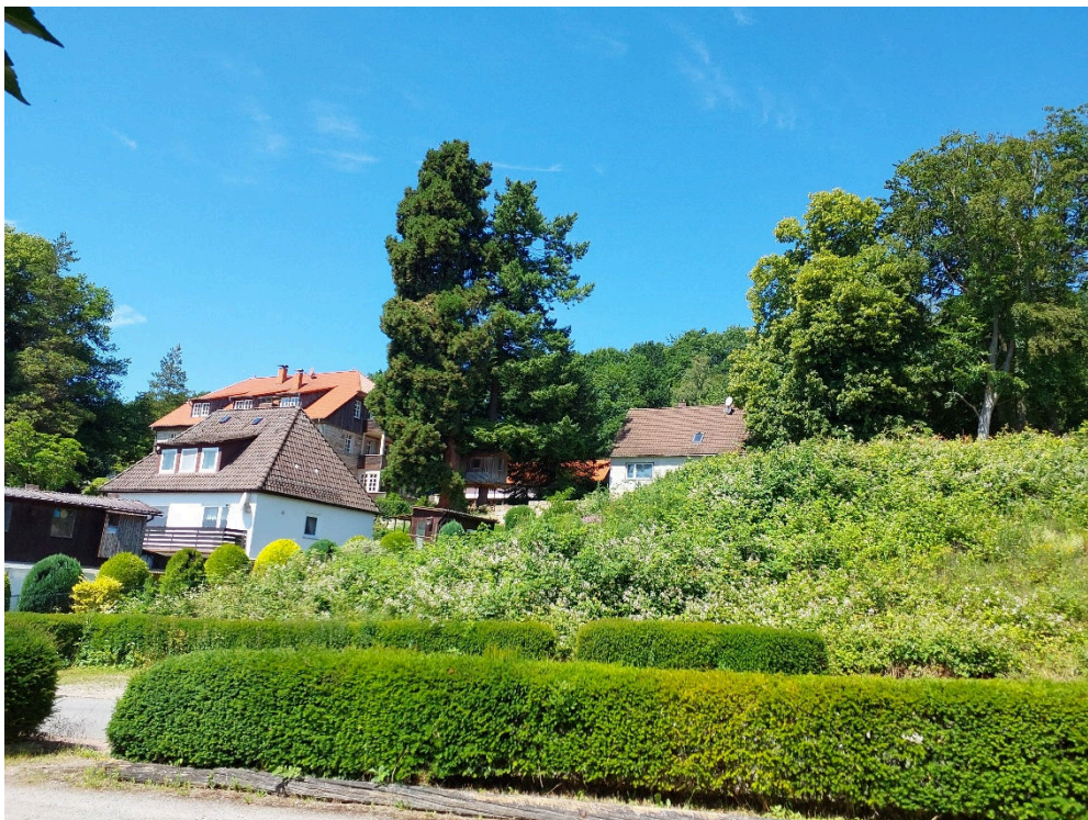
Abb. 10: Hangkante mit Rubusgestrüpp im Süden mit vorgelagerten Parkplätzen
