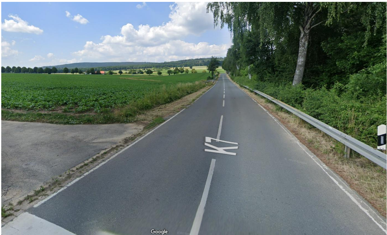
Blick von Gleisanlage Richtung Norden / B1 (Google-Street-View, Juni 2023)
