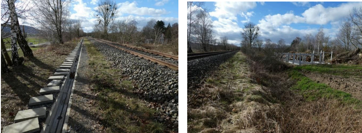
Abb. 9: Randbereiche der Gleisanlage Bahnlinie von Elze nach Hameln
