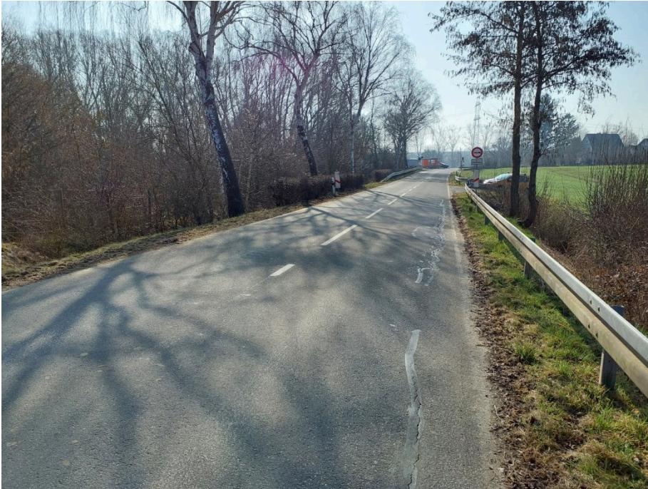
Abb. 10: Kreisstraße K 7 im Osten
