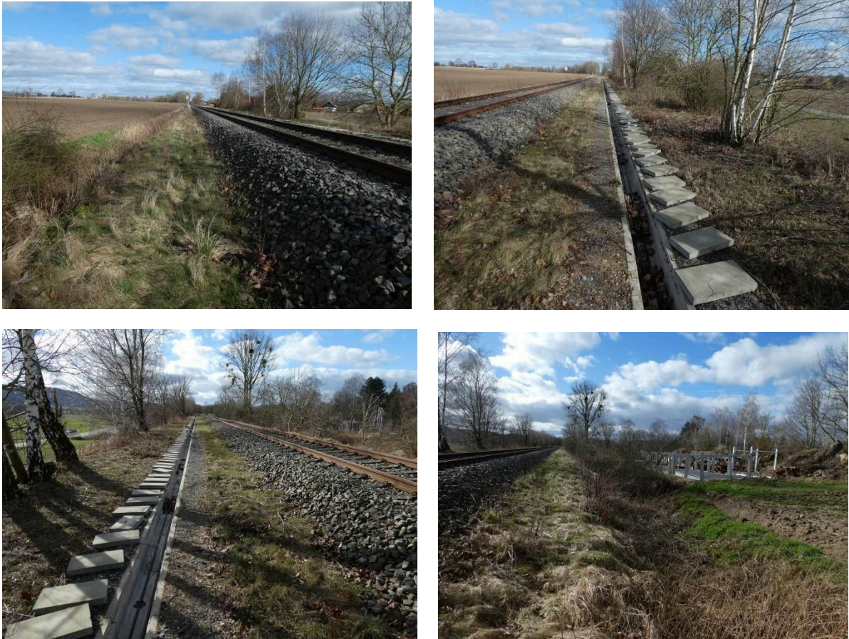
Abb. 8: Randbereiche der Gleisanlage Bahnlinie von Elze nach Hameln
