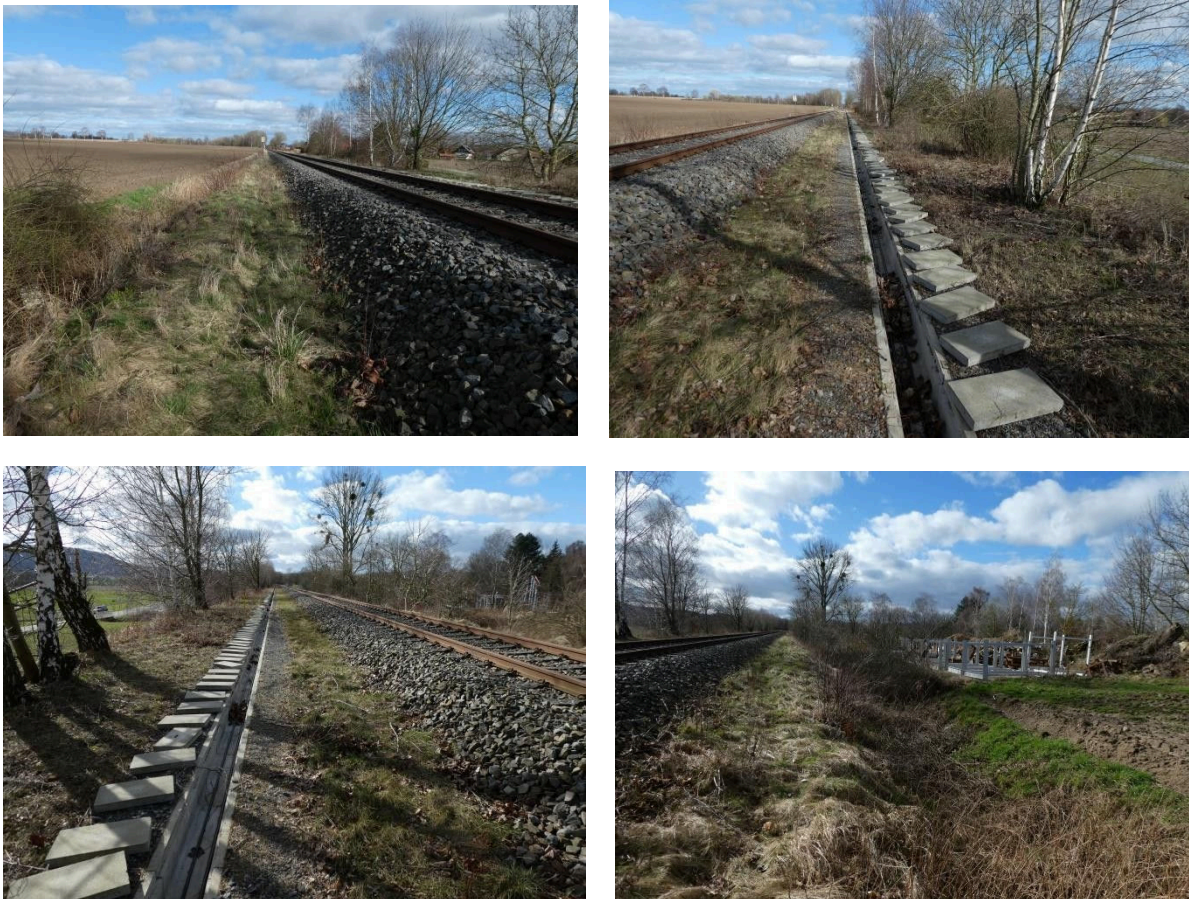
Abb. 12: Randbereiche der Gleisanlage Bahnlinie von Elze nach Hameln
