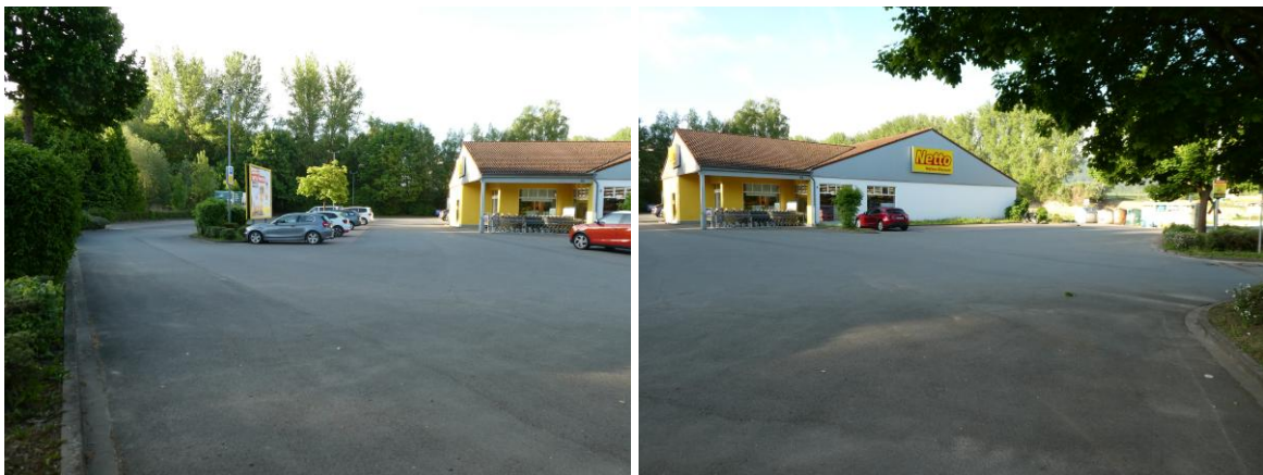
Abbildung 1: Die Fotos zeigen das Supermarktgelände mit dem östlich und nördlich des Gebäudes gelegenen, durchgehend versiegelten Parkplatz. Der Verlauf der Saale befindet sich auf dem linken Foto nahe der linken hinteren Ecke des Parkplatzes im dort zu erkennenden Gehölz.
