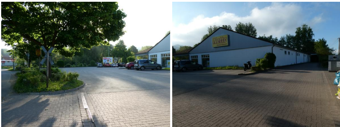
Abbildung 2: Diese beiden Fotos sind entlang des Quellwegs, also von Nordwesten aus aufgenommen und zeigen die Nordfassade des Gebäudes, den nördlichen Teil des Parkplatzes und die westlich gelegene LKW-Zufahrt für den LKW-Verkehr. Rechts der Einfahrt außerhalb des Bildrandes verläuft die alte Bahntrasse.
