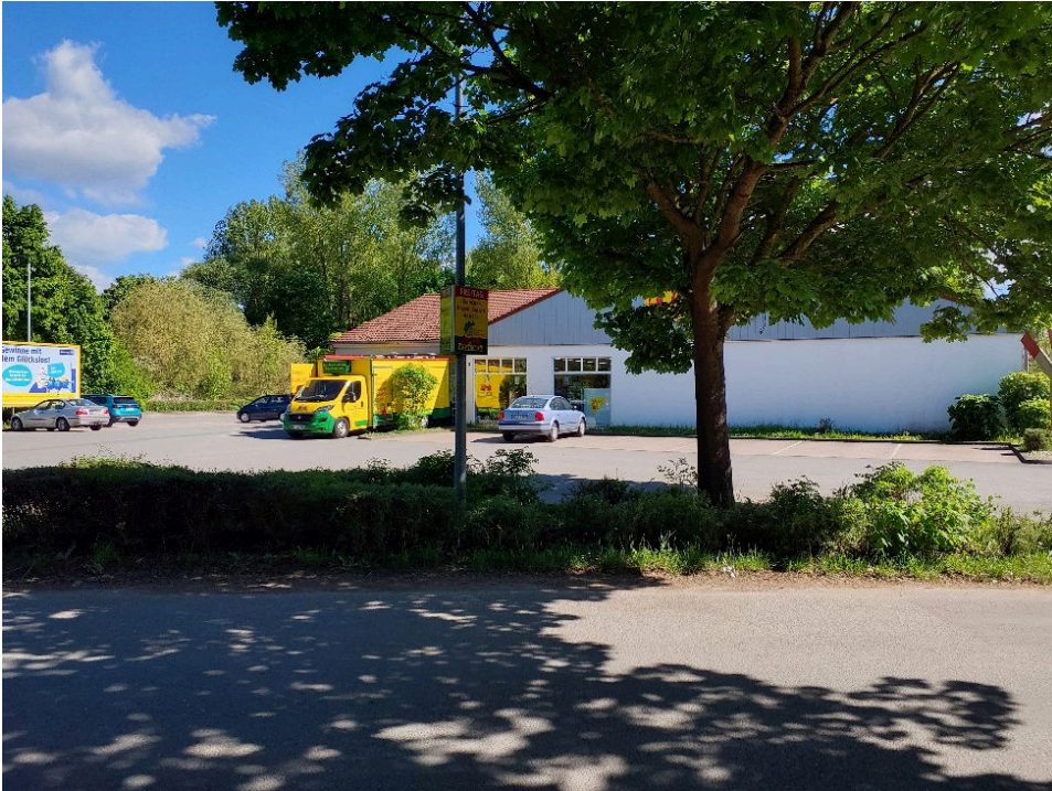
Abb. 7: Bestandsgebäude von Osten
