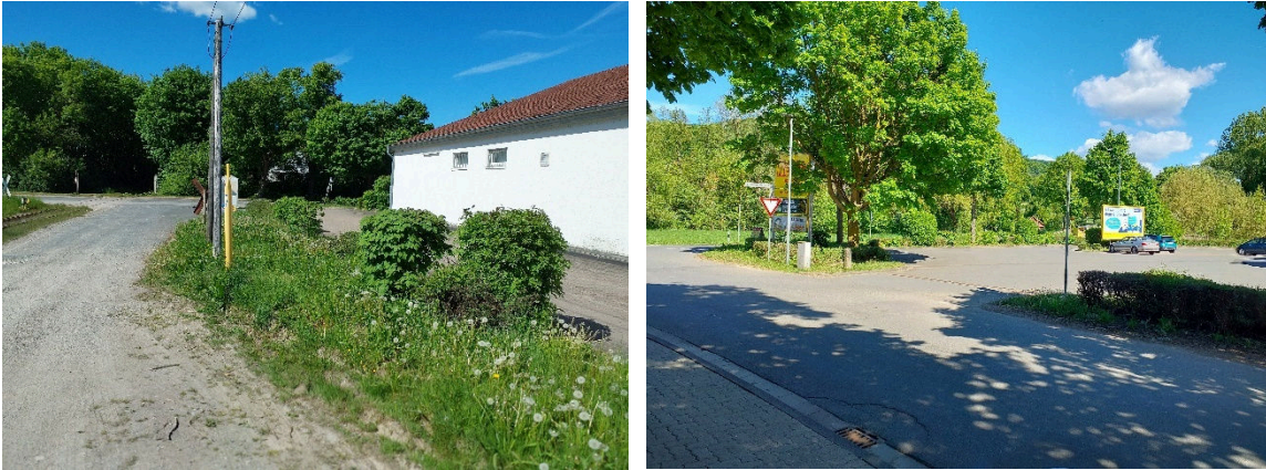
Abb. 9: Bestandsgebäude und Parkplatz
