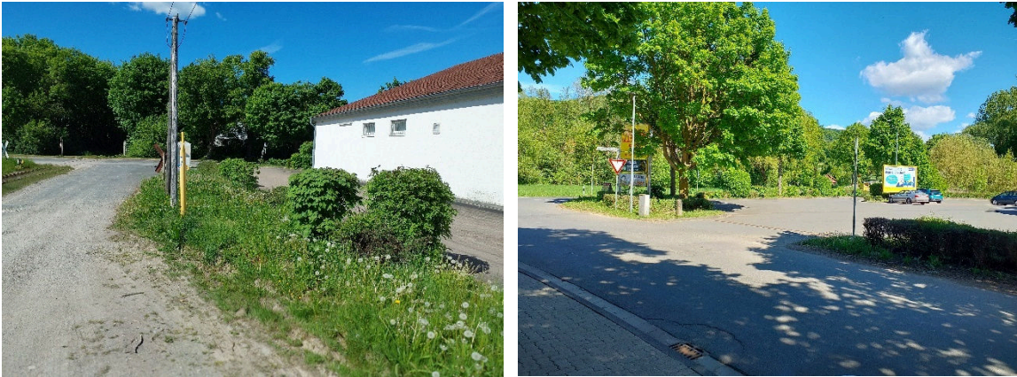
Abb. 5: Bestandsgebäude und Parkplatz
