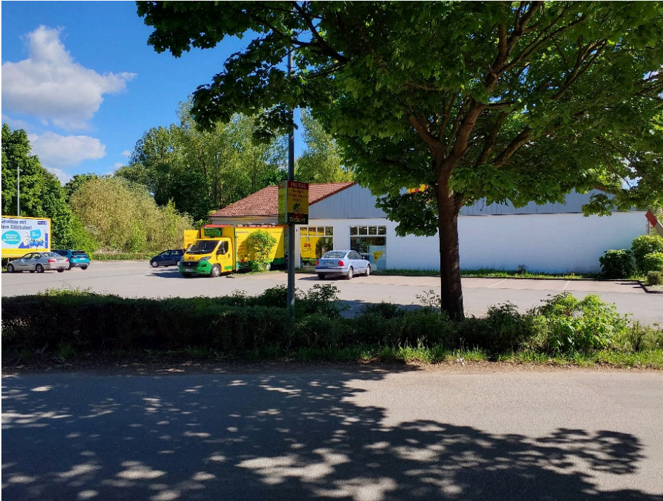
Abb. 3: Bestandsgebäude von Osten
