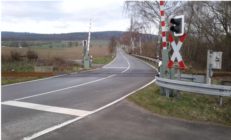
K 7 Bahnübergang, Blickrichtung Norden zur B 1
